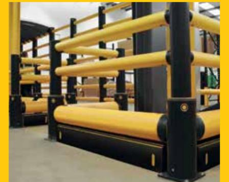
iFlexフォークガードが、製造工場のクレーンコラムを防護しています。
