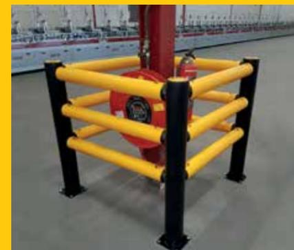
iFlexコラムガードが、配送施設の水道配管を防護しています。
