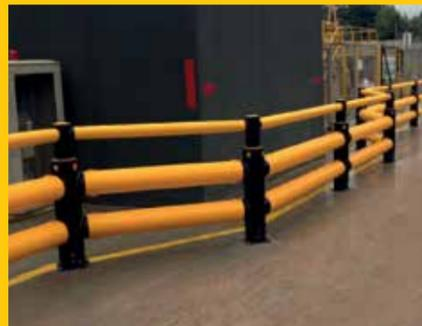
iFlexダブル車両バリア+により、重車両から歩行者を防護しています。
