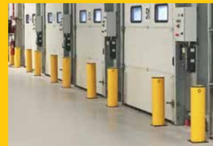
ポラードにより、ドアフレームとシャッターレベルを防護しています。
