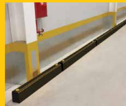
eFlexフォークガードが、配送センターの壁を床面レベルで防護しています。
