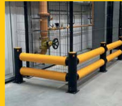
iFlexダブル車両バリアが、食品工場のスプリングロー装置を防護しています。
