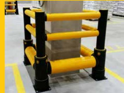
iFlexコラムガード+が、高衛生レベルの環境で柱の防護に用いられています。
